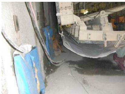
シート型枠台車へのシート防水材巻揚げ状況
