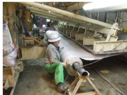
シート型枠台車へのシート防水材巻揚げ状況
