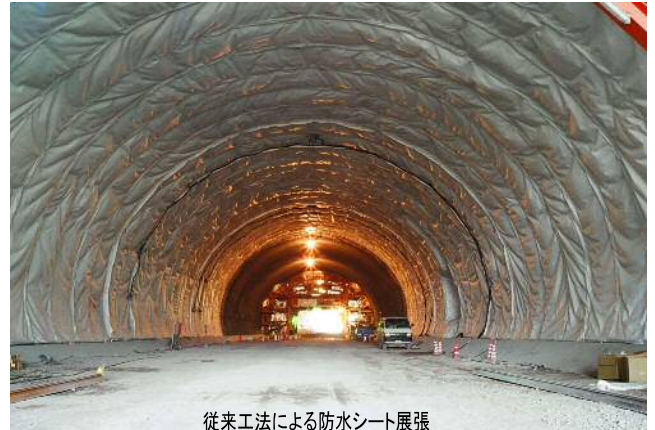
従来工法による防水シート展張
