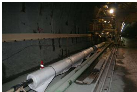
幅広シート防水材の配置状況
