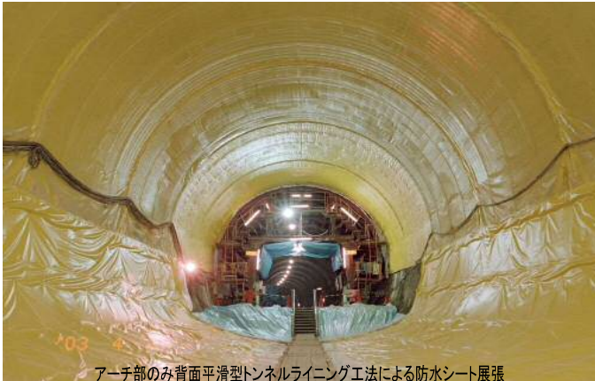
アーチ部のみ背面平滑型トンネルライニング工法による防水シート展張
