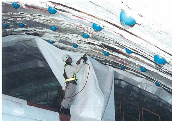
中間裏止めテープの固定
