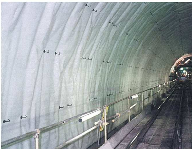
吊り鉄筋金具
