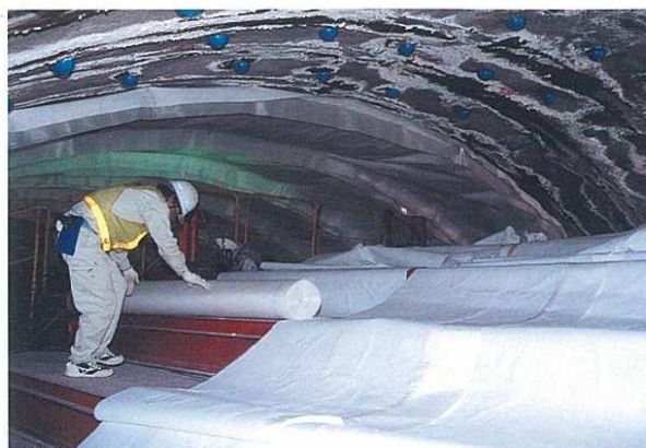
足場上にシートロールを上げる
