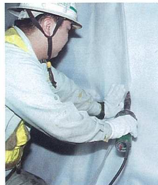
熱風溶着機でシートを倒す
