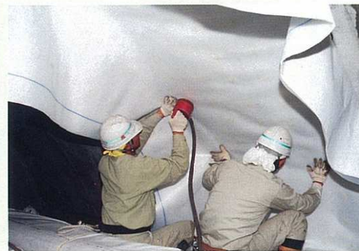
ディスクウエルダー（電磁誘導溶着機）
