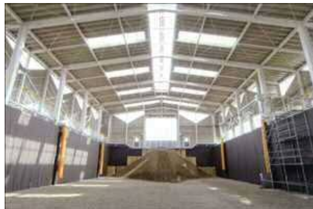
施工例:被覆式最終処分場遮水工事
