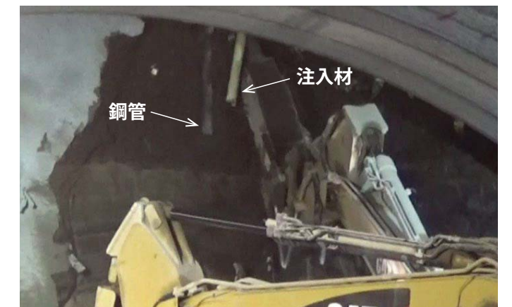
AGF-Me工法の切除状況
