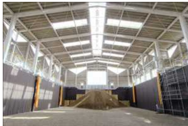
施工例：被覆式最終処分場遮水工事
