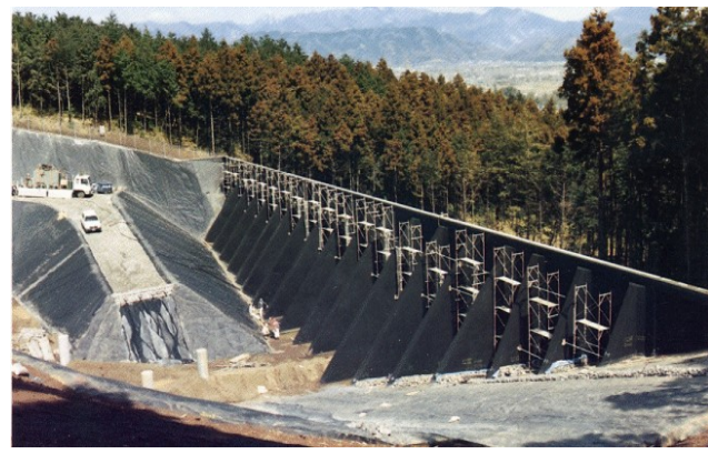
調整池遮水工事
